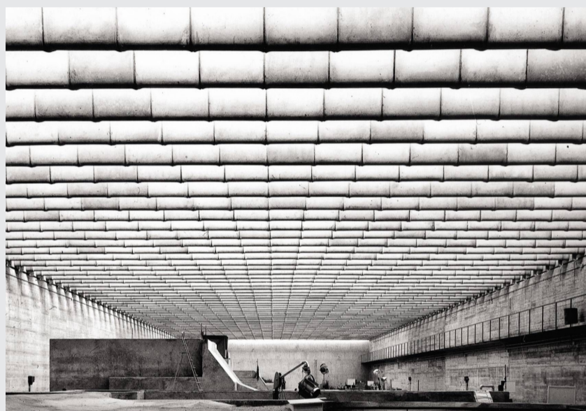
Centro de Estudios Hidrográficos, Miguel Fisac, 1960-1963
