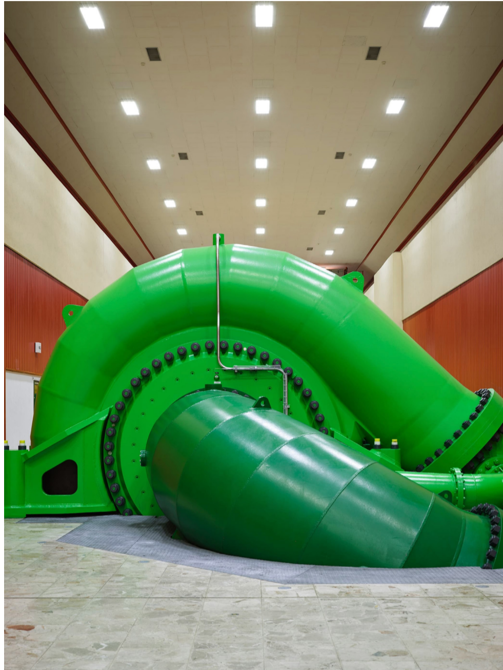
Claudia Christen, Pumpspeicherwerk Grimsel 2
