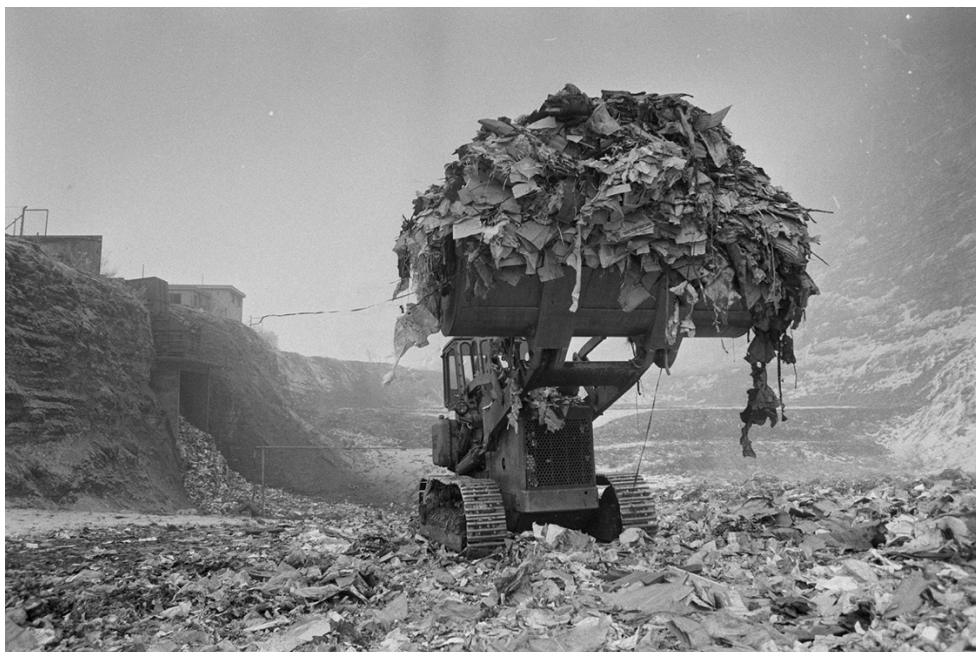
Abfalldeponie Bärengaben in Würenlingen, 1970
