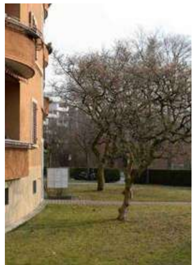
Bâtiment à côté Hardtturm
