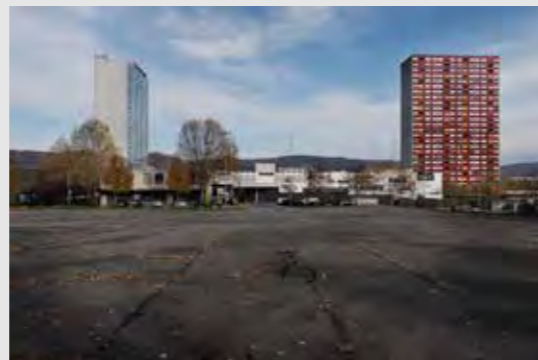
Das Shoppingcenter Spreitenbach umgibt viel Asphalt. Im Hintergrund die «Leberwurst» (mit dem Schriftzug Shoppi Tivoli) und «Blutwurst» genannten Scheibenhochhäuser von 1970. (Bild: Karin Hofer / NZZ)
