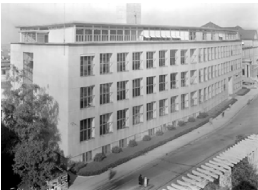
Maschinenlaboratorium und Fernheizkraftwerk, ETH Zürich, 1935 Otto Rudolf Salvisberg
