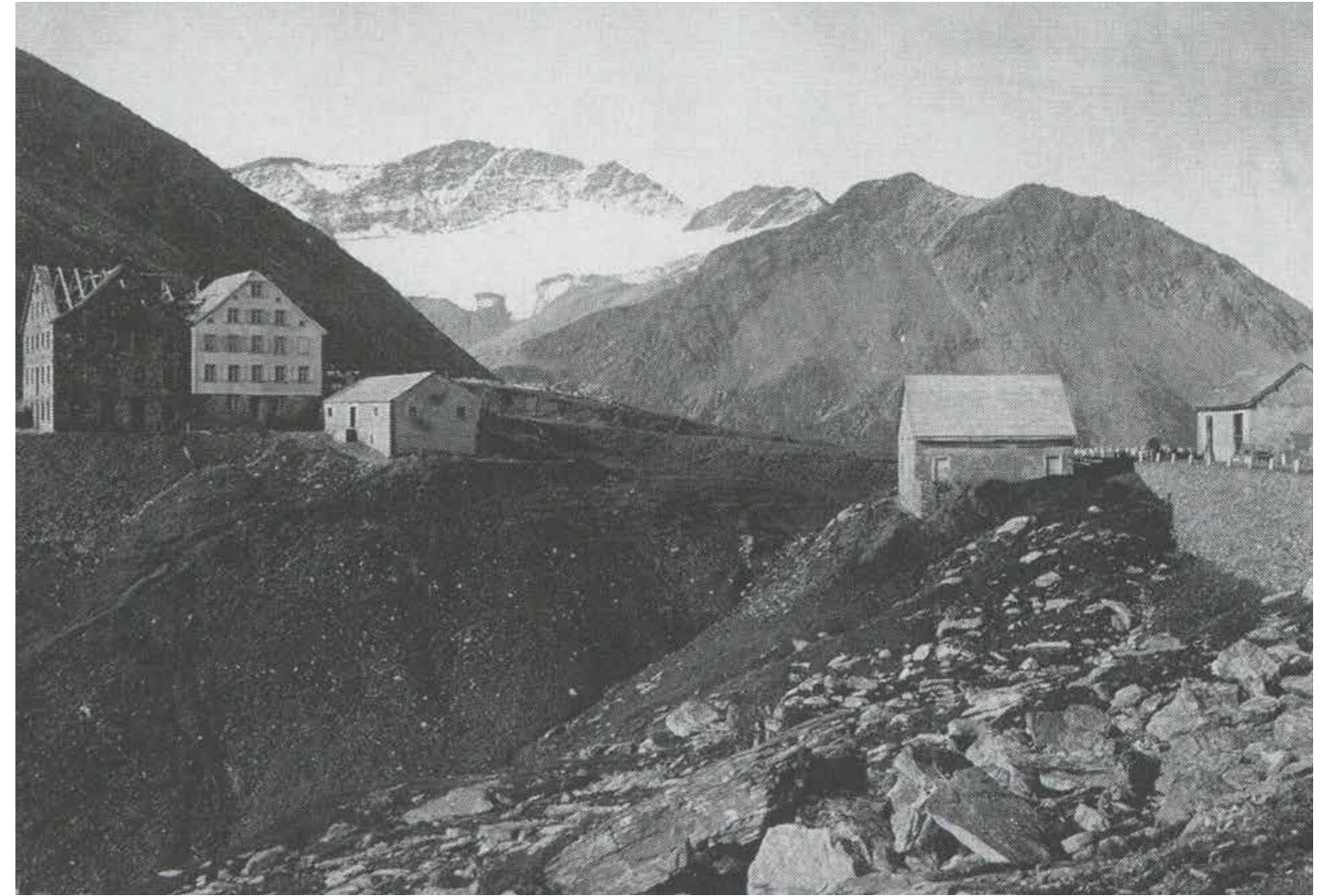
Furka Hotel during its extension, 1888/1889 In Roland Flückinger-Seiler, Berghotels Zwischen. Alpweide und Gipfelkreuz. Alpiner Tourismus und Hotelbau 1830-1920 . Hier und Jetzt Verlag, 2015
