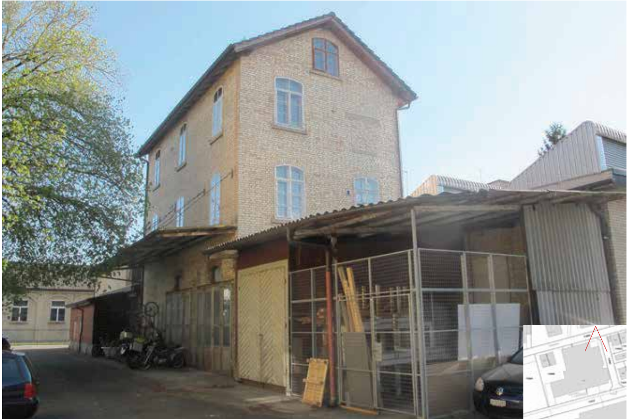
4 Blick Rückseite auf das ehemalige und aufgestockte Aperaturgebäude
