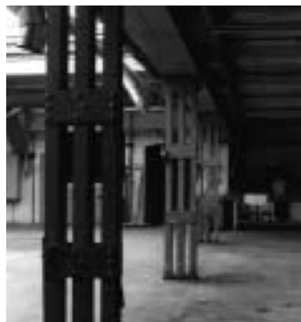
genietete Eisenträger zwischen dem Webe- rei-Hochbau und der Halle
