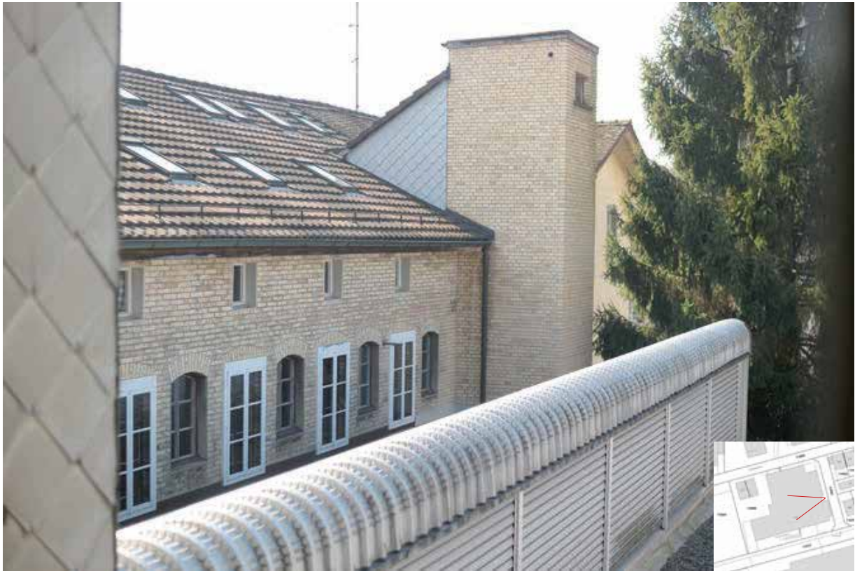
3 Blick über das Sheddach, stillgelegter Liftschacht
