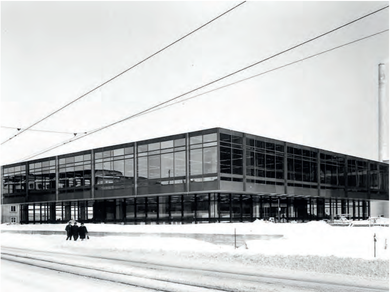
Bau 610 (Archiv Suter + Suter)
