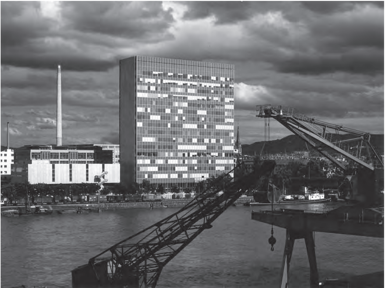
Bau 125 (Archiv Suter + Suter)
