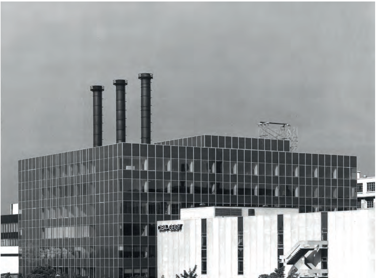
Bau 127 (Archiv Suter + Suter)
