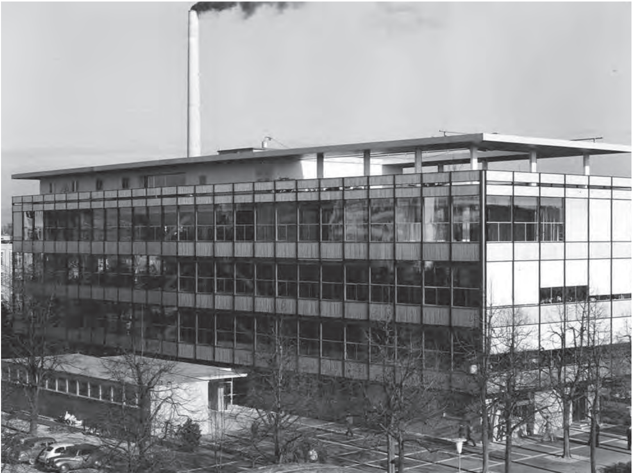
Bau 430 (Archiv Suter + Suter)
