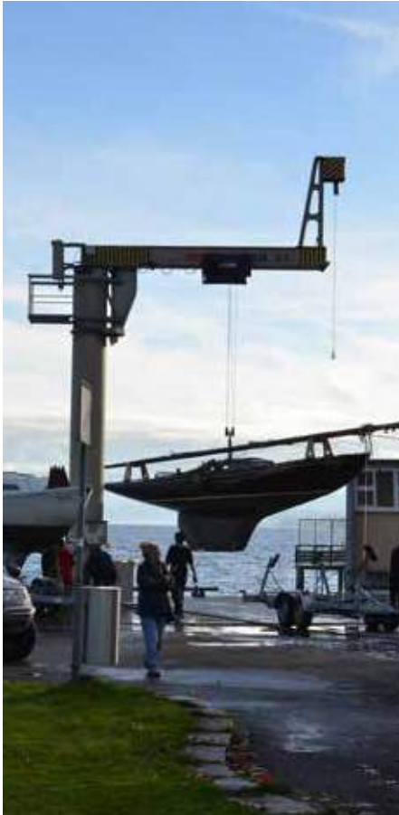
Krananlage Mythenquai, November 2018
