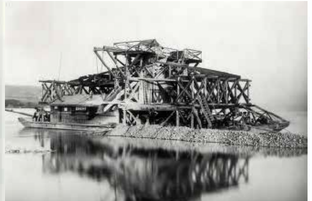
Der Erbauern der Quaalagen stand ein eindrücklicher Maschinenpark zur Verfügung. Schwimmende Bagger für die Förderung von Kies und Schlamm, ferner sogenannte Elevatoren, die zur Entladung der Transportschiffe dienten. Die grösstenteils aus Mainz stammenden Maschinen trugen Namen wie «Hund», «Kotz» usw.
