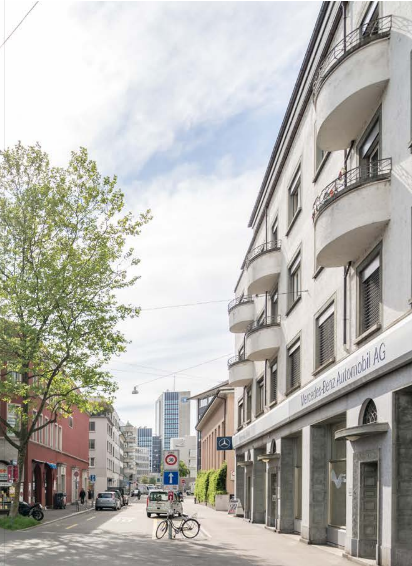
↑ Blick Ecke Badenerstrasse/ Grüngasse
